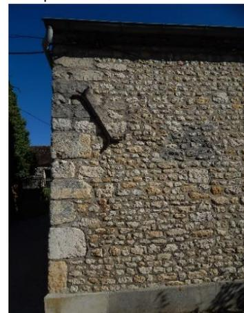
Traditionnellement les murs des maisons d'habitation disposaient d'un enduit couvrant. Les murs pignons pouvaient cependant être à pierre vue. Il est primordial de conserver ces enduits car ils protègent les pierres et les joints de la pluie, du vent et du gel. L'enduit présente également l'avantage de masquer l'appareillage peu gracieux des murs de moellon.
