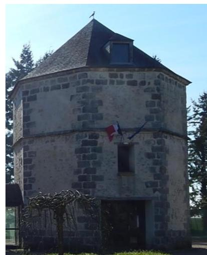
Le pigeonnier de Guercheville de forme octogonale était isolé des bâtiments où logeaient les bêtes et les gens. La tour est aveugle mise à part la porte au rez-de-chaussée permettant aux exploitants d'y pénétrer et la lucarne permettant l'envol des pigeons. La toiture en ardoise est couronnée d'un épi de faîtage figurant un pigeon au repos permettant aux volatiles de reconnaître leur demeure.
