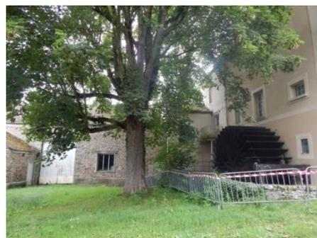
La roue à aubes du moulin de la Fosse était couverte d'un abri, aujourd'hui, cet abri a disparu. Un déversoir se trouve devant pour permettre à l'eau de faire fonctionner la roue. L'ensemble était protégé par une échelle permettant d'arrêter les débris.
