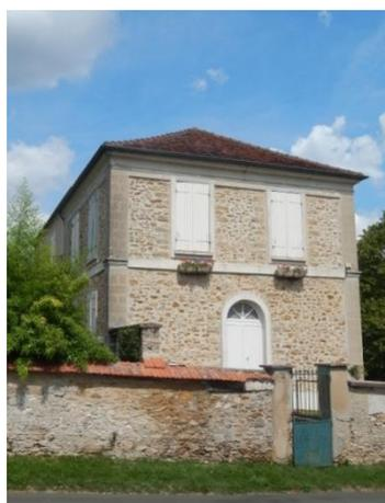
Aujourd'hui ce bâtiment est exclusivement dédié à l'enseignement. Sa façade principale est ordonnancée avec un enduit couvrant. Les élévations secondaires sont composées d'un appareil mixte formé essentiellement de meulière et de grès avec un enduit à pierre vue à la chaux. On note la présence de chaînage d'angle, de corniches et de bandeaux.
