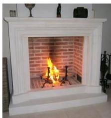
Une cheminée à foyer ouvert est une cheminée traditionnelle sans vitre. Le foyer est constitué d'une niche aménagée dans le mur et d'un conduit d'évacuation de fumées. Ils ne peuvent pas être considérés comme un mode de chauffage compte tenu du **faible rendement** (environ 10%, les 90% restant partent dans les fumées).
