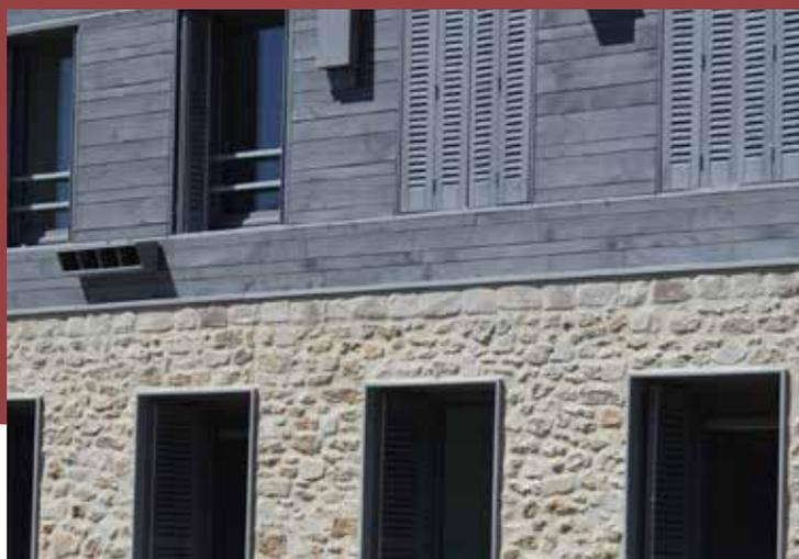
L'utilisation de **matériaux locaux** permet de réduire les émissions de gaz à effet de serre du projet en limitant les distances liées à leur transport.
