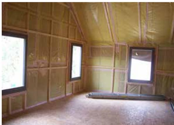
**Les murs extérieurs de la Maison du Parc permettent donc de limiter les déperditions thermiques.**
