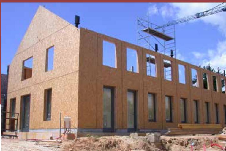
La Maison du Parc est **une construction à ossature bois**. Cela permet d'une part la préfabrication en atelier et d'autre part la réalisation du bâtiment en filière sèche.
