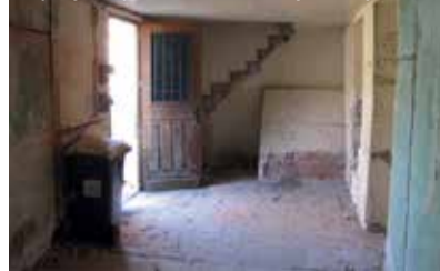
Pièce du rez-de-chaussée avant travaux et projet après rénovation (virtuel)
