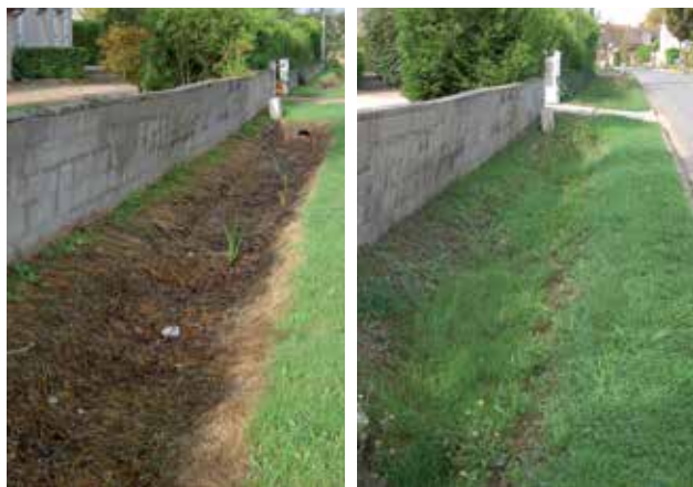
Arrêt du désherbage dans les caniveaux, La Chapelle-la-Reine (avant/après)
