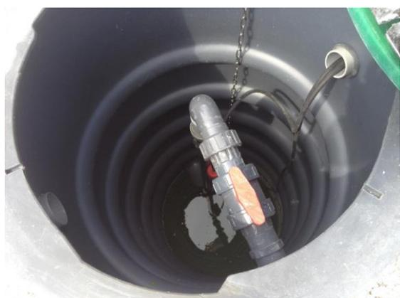
✚ Il faut s'assurer que le flotteur ne soit pas coincé et vérifier son fonctionnement en l'enclenchant manuellement, pour éviter tout risque de débordement ;
