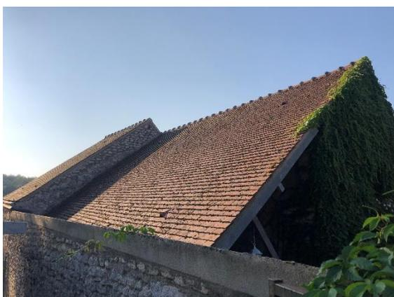
Figure 115 - Toiture en tuiles plates
