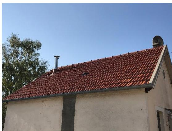
Figure 114 - Toiture en tuiles mécaniques
