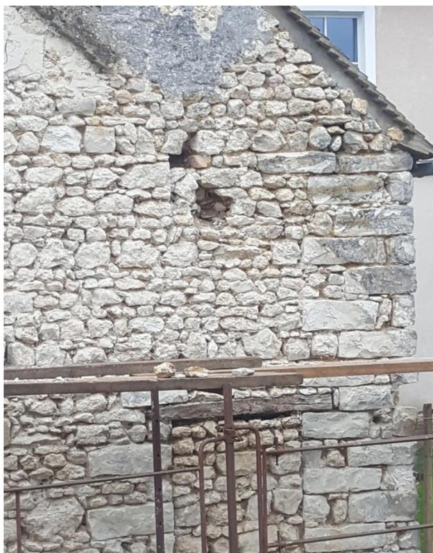
*Ravalement de façade présentant les matériaux emblématiques du territoire : grès et calcaire sous forme de moellons (pour le mur) et de pierres de taille (pour le chaînage d'angle).*
