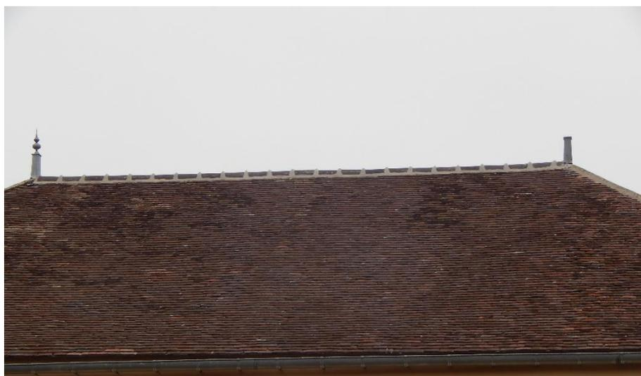
*Exemple de toiture recouverte de tuiles plates et agrémentée d'épis de faîtages. Les épis de faîtages sont conçus à l'origine pour protéger le sommet de la charpente. Ils ont souvent aujourd'hui une valeur uniquement esthétique.*
